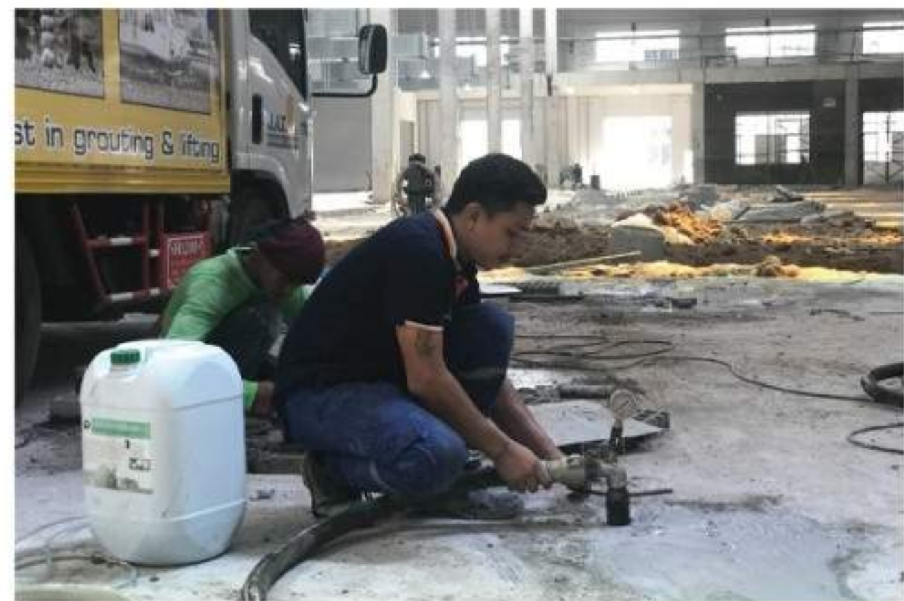
ติดตั้งสาย และหัวฉีดวัสดุ โดยการฉีดวัสดุจะใช้แรงดัน ประมาณ 2,000-3,000 PSI
