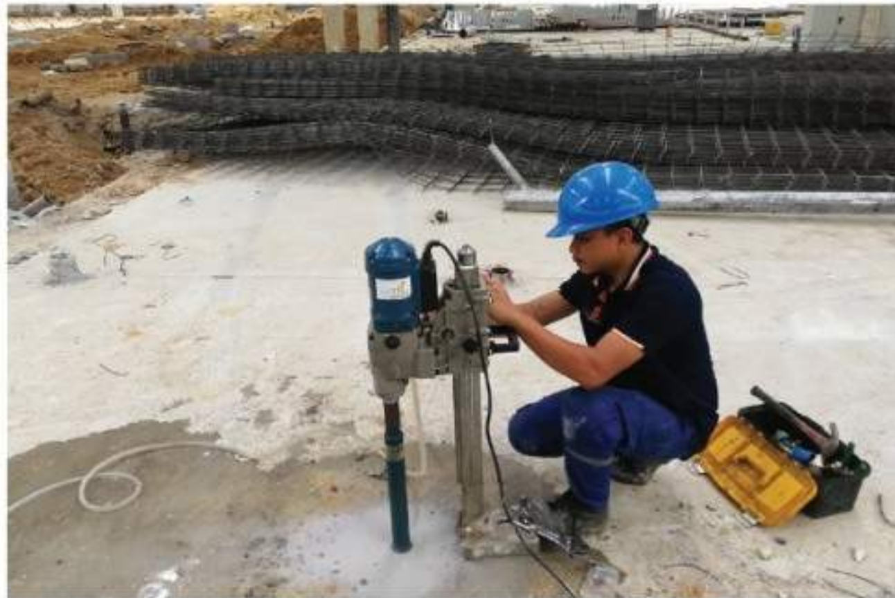
งานวางตำแหน่งและทำการเจาะคอนกรีตขนาด เส้นผ่าศูนย์กลาง 1.5 นิ้ว
