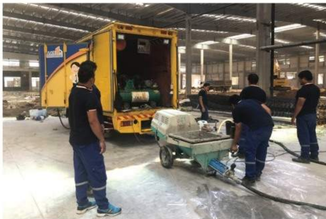
ติดตั้งเครื่องมือและอุปกรณ์ เช่น บีมซีเมนต์, บีมลม, เครื่องผลิตฟองโฟม และเครื่องกำเนิดไฟฟ้า
