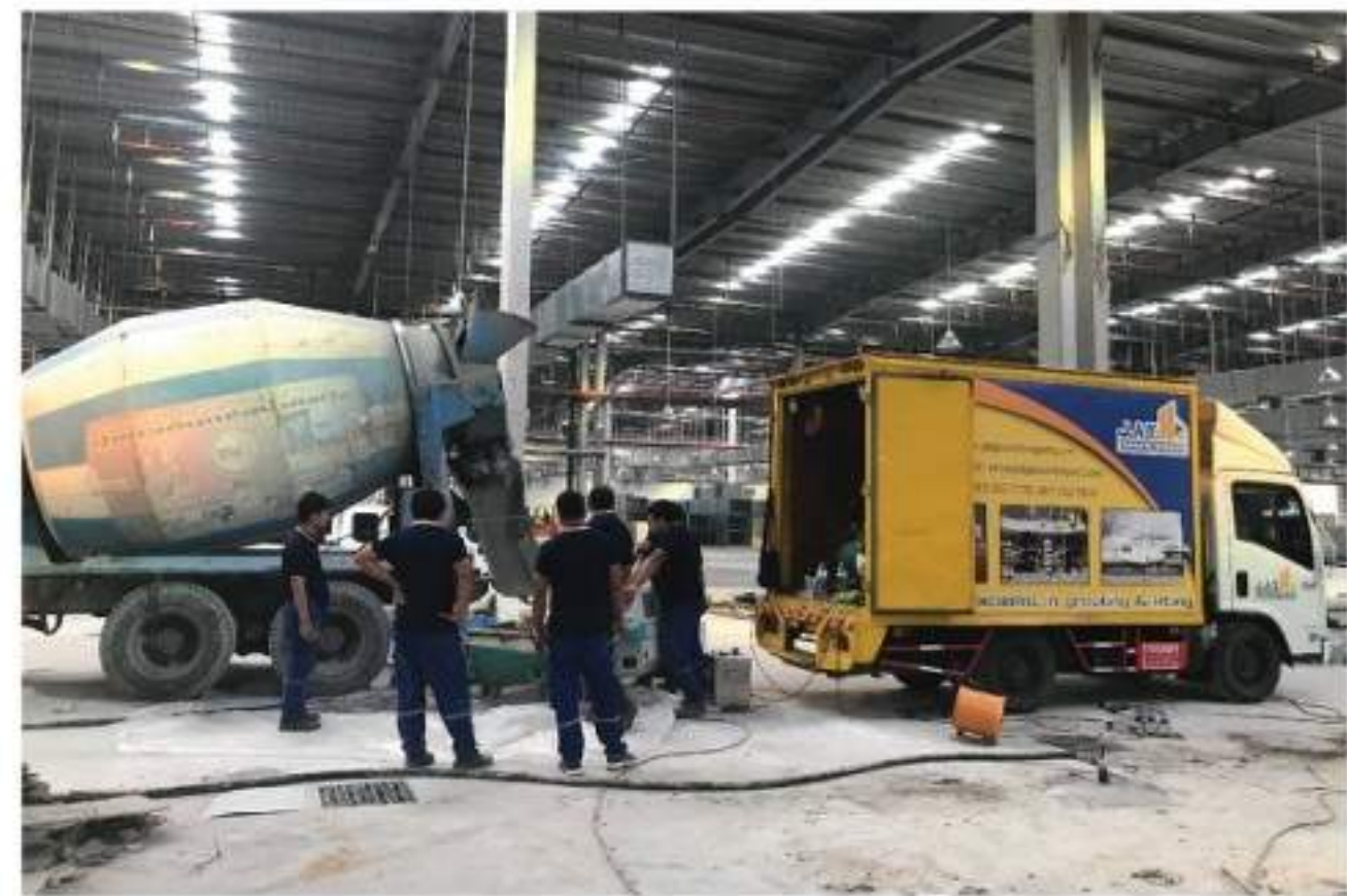
วัสดุจะถูกอัดจนกว่าจะกระจายตัวเต็มพื้นที่ โดยจะ สามารถสังเกตได้จากหลุมเจาะข้างเคียง หรือสังเกต จากแรงดันที่เกิดขึ้นที่ Pressure Gauge
